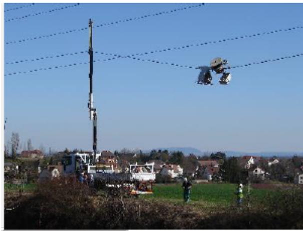
On pourra aussi constater sur les photos que ce robot d'un certain poids fait descendre la ligne électrique qui le supporte au niveau des branches des arbres.
